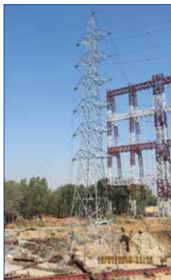
800 kV HVDC String
