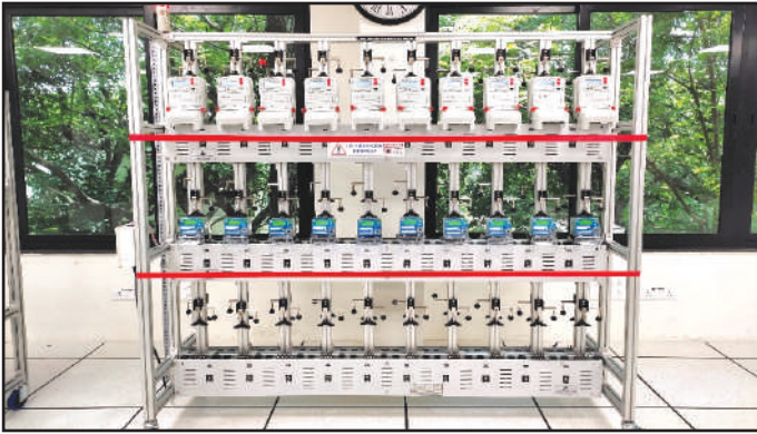
उन्नत मीटरिंग अवसंरचना प्रणाली प्रदर्शन परीक्षण
